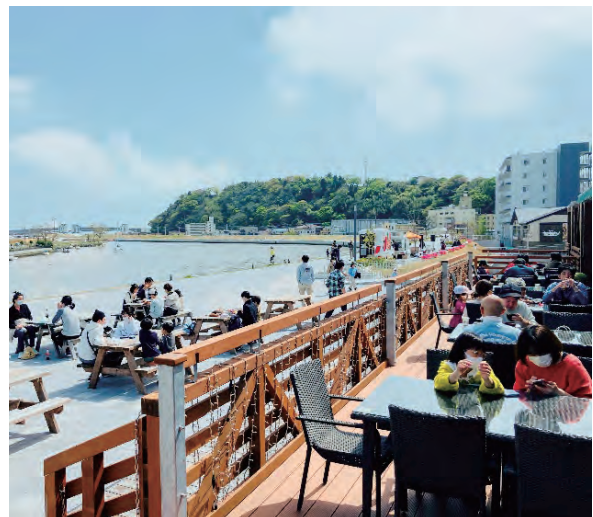
石巻市の河川堤防を活用した交流施設
