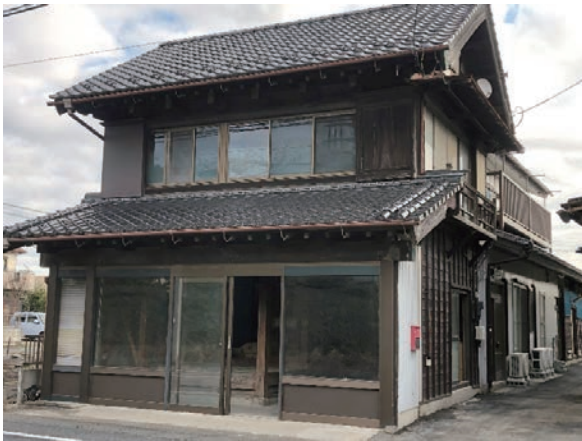
シェアハウスに改修した製麺所跡
