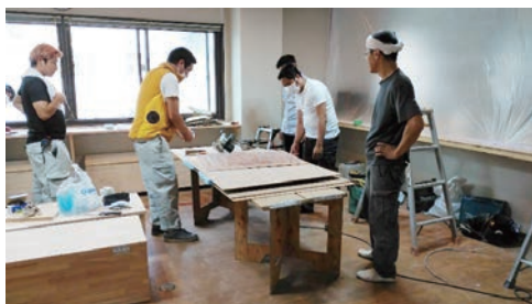
建設インターンシップの様子
