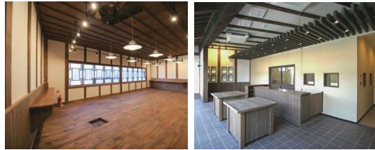
保存した2階部分
