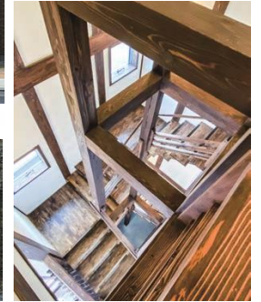
新設した3階までの階段
