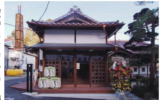
外観改修の様子。耐震補強では格子耐力壁を活用
