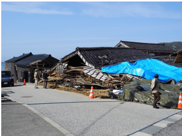
倒壊した旧角海家住宅
