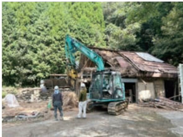
牛小屋の解体
